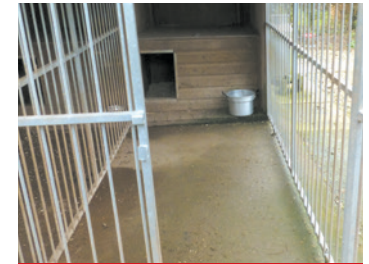
Perreras con suelos de cemento son más fáciles de limpiar y reducen el riesgo de infección
